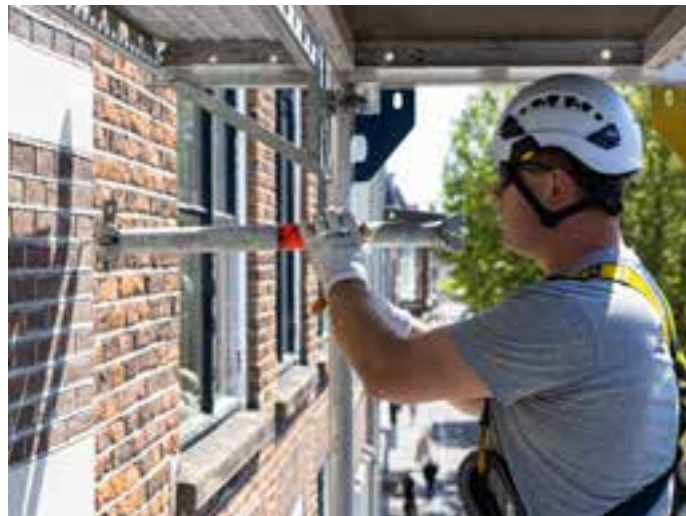
HET AANBRENGEN VAN MUURANKERS IS BEDOELD OM DE STEIGER AAN HET PAND TE VERANKEREN.
